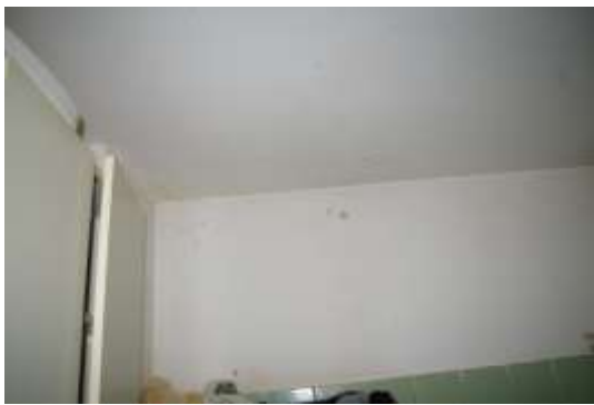
Dzīvojamā ēka ar kadastra apzīmējumu 1700 044 0118 001, dzīvoklis Nr.18, telpa Nr.
